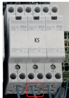
Rys. 94. Podłączenie pompy zaworu mieszającego 1
