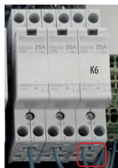
Rys. 95. Podłączenie pompy zaworu mieszającego 2
